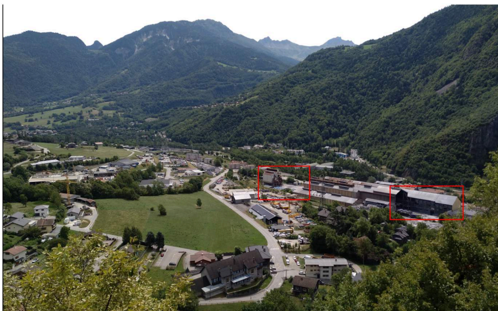
Figure 11 : L'usine de Château-Feuillet, en cours de transformation. En rouge : les secteurs démolis ou en cours de démolition.
